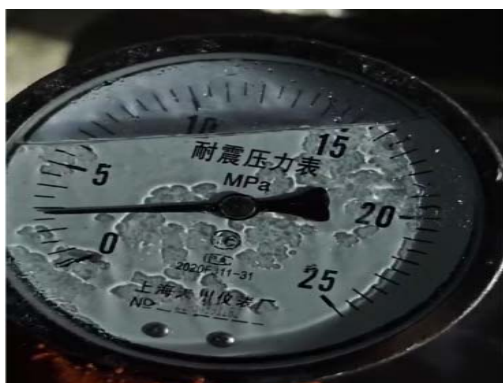
图2 引水支洞泄水孔水压力测试(3Mpa)
