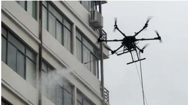
图1 无人机清洗楼面
